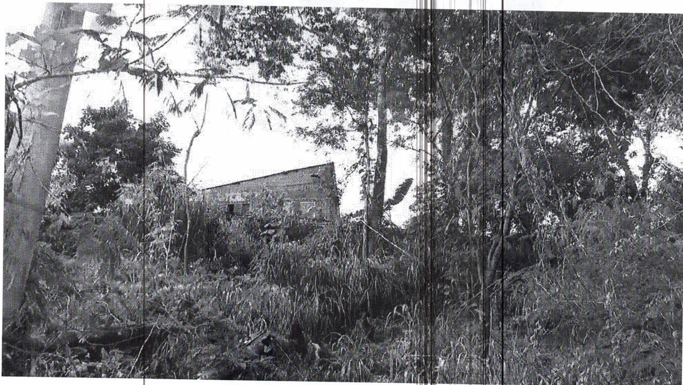
Casas no Jardim Brasilândia então em risco após chuvas em Franca (Foto: Jeferson Severiano Neves/EPTV)
